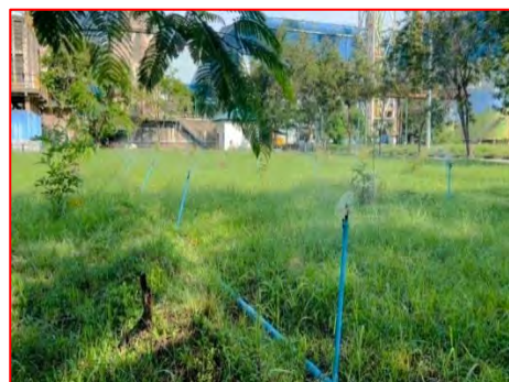
ภาพที่ 2-15 การนำน้ำทิ้งภายหลัง การบำบัดมารดน้ำต้นไม้
