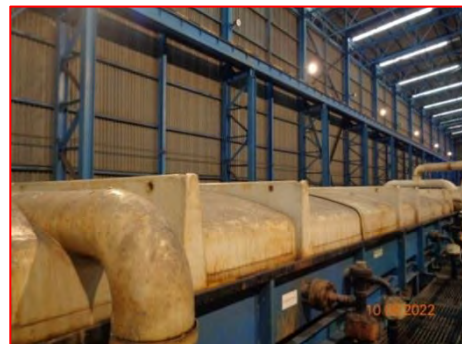
ภาพที่ 2-5 ระบบรางที่มีฝาปิดและมีเครื่องดูด รวบรวมไอกรดใน Pickling Oil Plant
